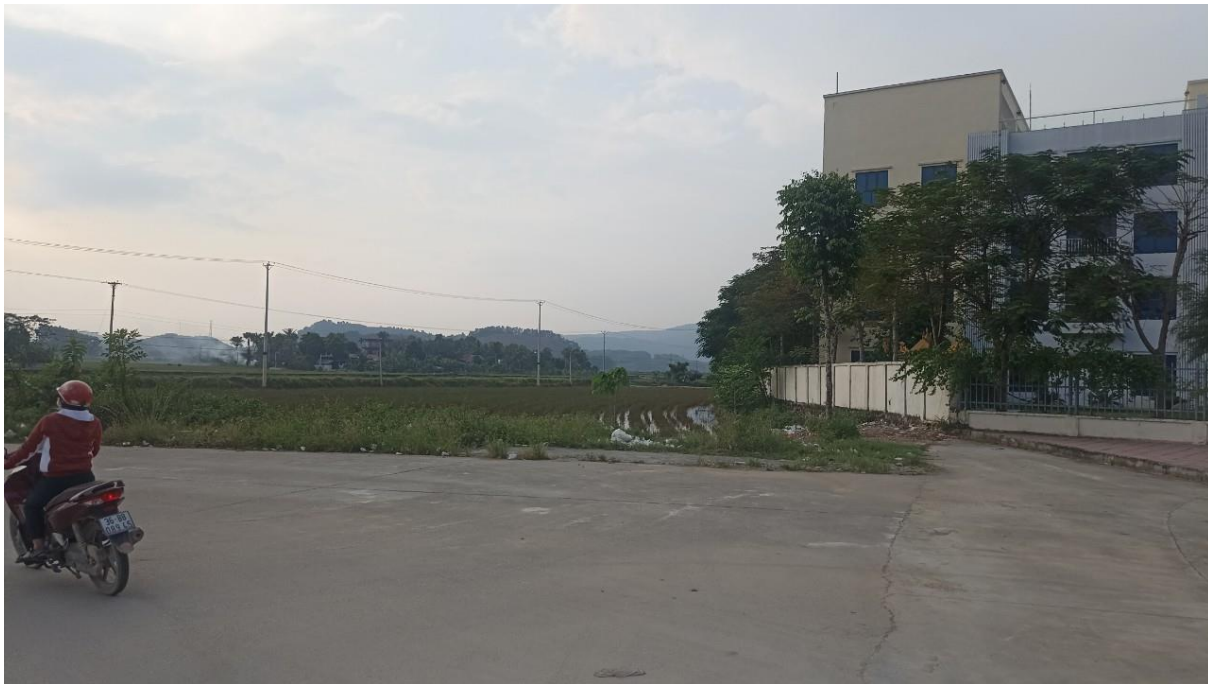
Hình 1.2. Hiện trạng khu đất thực hiện dự án
