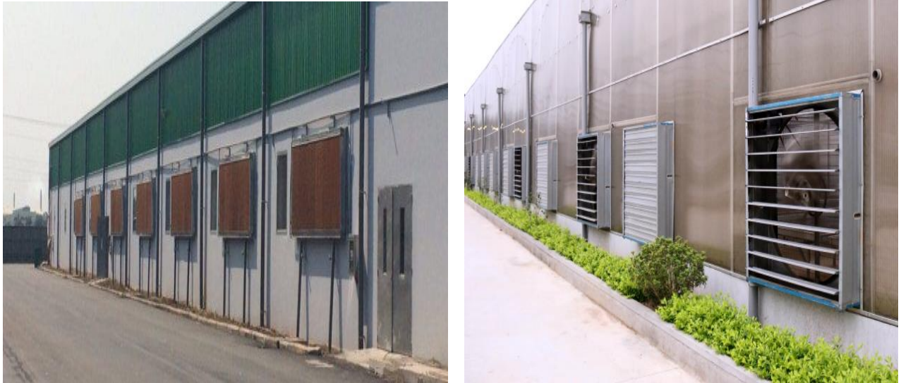
Hình 3.1. Hình ảnh bố trí hệ thống thông gió tại nhà xưởng
